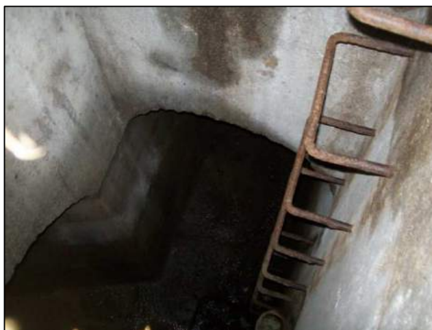
Intérieur de l'ancien captage communal
